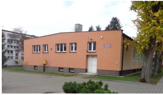
A - stołówka - elewacja południowa
