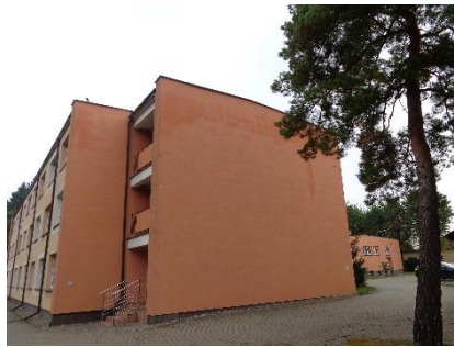
C- prawe skrzydło mieszkalne - elewacja południowa
