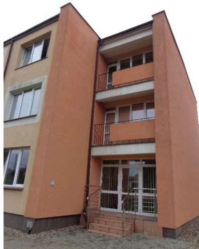
prawe skrzydło mieszkalne - elewacja zachodnia balkony i loggie balkonowe
