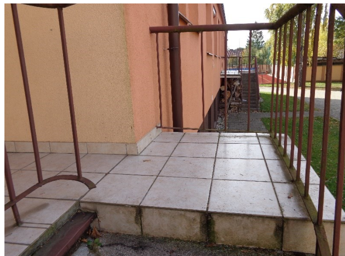
taras i schody - elewacja północna
