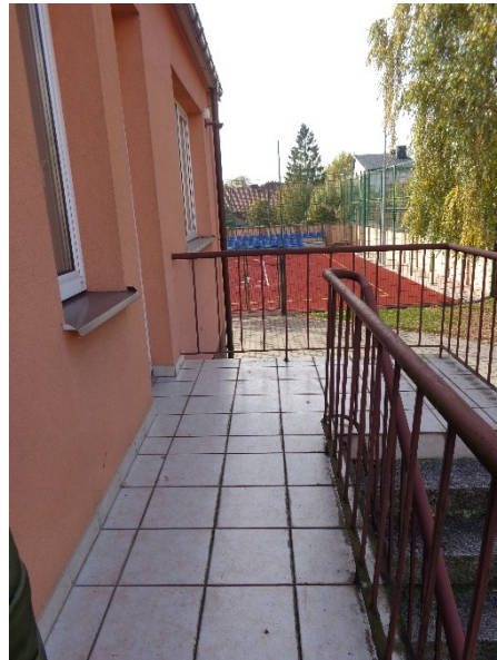
taras i schody - elewacja północna
