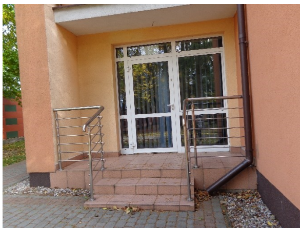
balkon i schody - elewacja północna,
